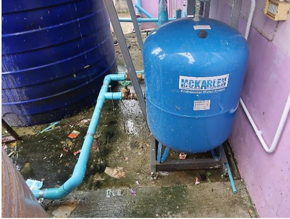
งานติดตั้งเครื่องสูบน้ำ และแนวท่อส่งน้ำ
