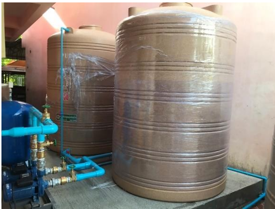
งานติดตั้งถังเก็บน้ำ ขนาด ๕,๐๐๐ ลิตร
