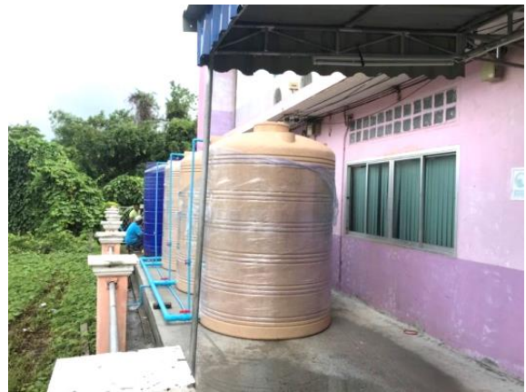
งานติดตั้งถังเก็บน้ำ ขนาด ๕,๐๐๐ ลิตร
